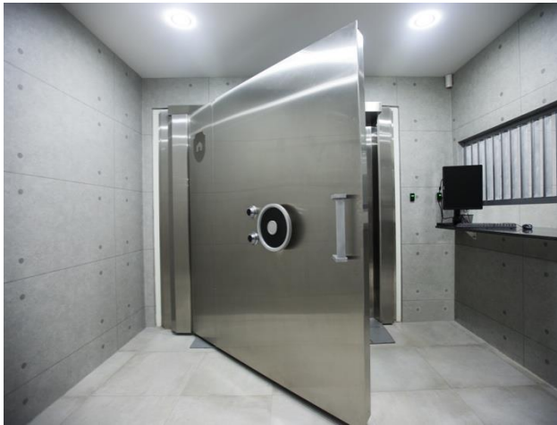
银胜子公司守富号，2.5 吨安全等级 1 级的安全门通往银库
